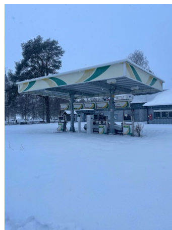
Äldre drivmedelpumpar under tak
