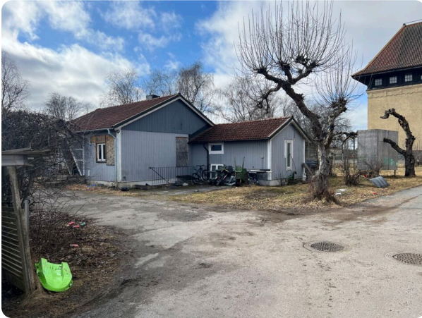
Bostadshus med grå fasad och vita detaljer samt parkering gräsmatta och träd
