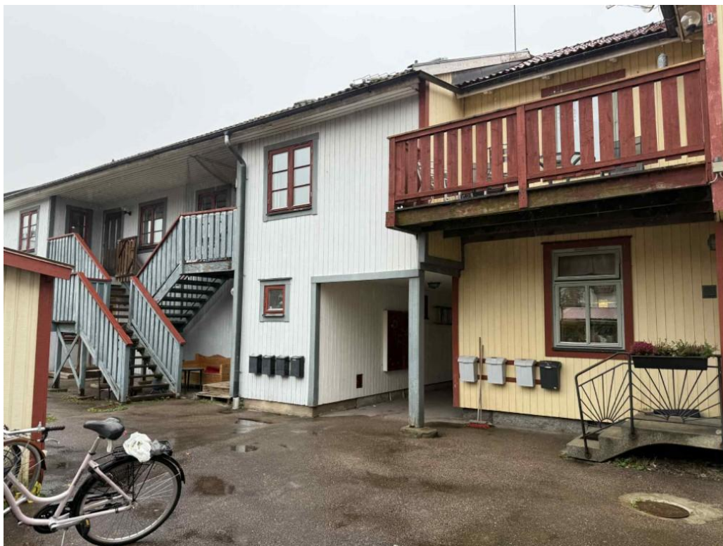
Foto taget utvändigt på värderingsobjektets huvudbyggnad. Gulmålad och gråmålad träpanel med röda och gråa detaljer samt asfalterad innergård.
