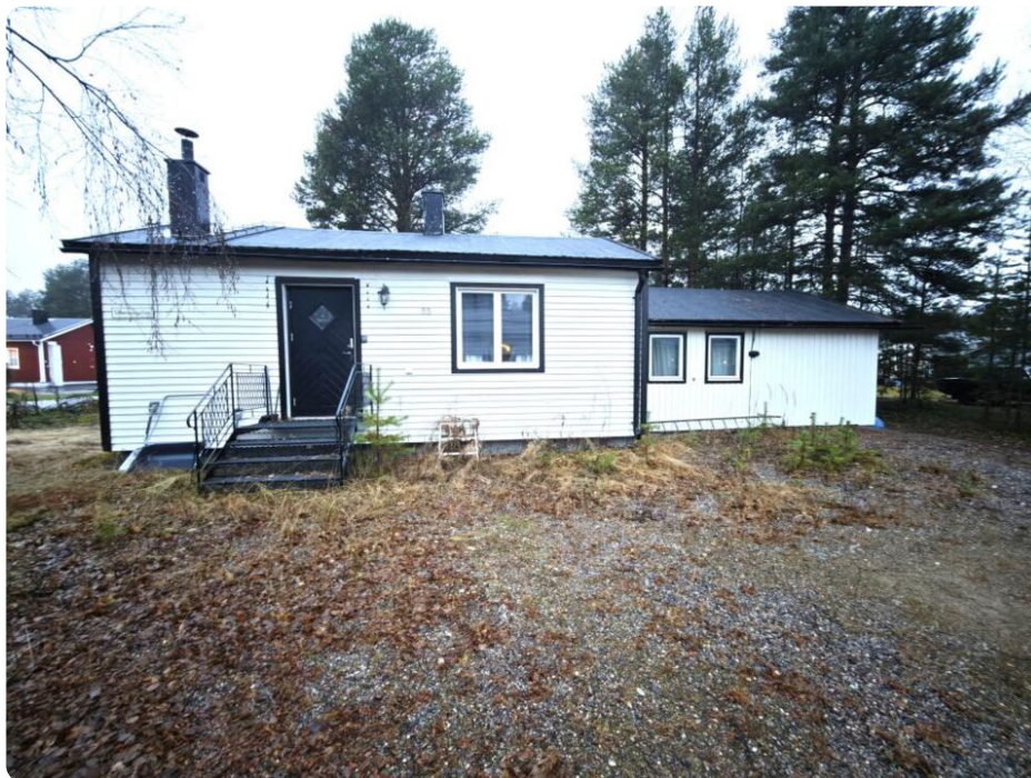
Foto huvudbyggnad, vit träpanel mörka detaljer, plåttak.
