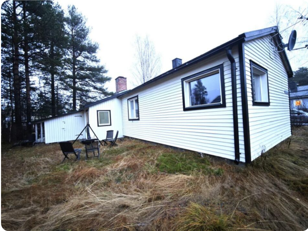
Foto huvudbyggnad, vit träpanel mörka detaljer, plåttak. Vidbyggt förråd.
