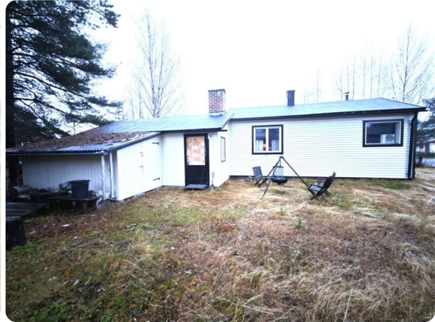
Foto huvudbyggnad, vit träpanel mörka detaljer, plåttak. Vodbyggt förråd.
