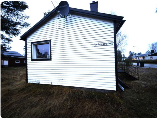
Foto huvudbyggnad, vit träpanel mörka detaljer, plåttak.
