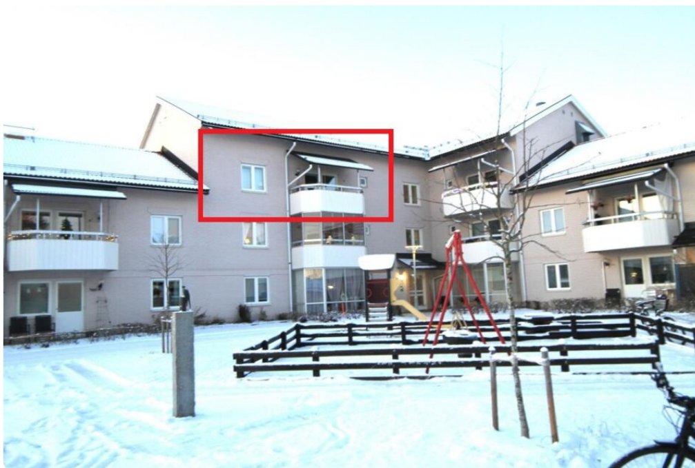
Foto huvusbyggnad i tre våningar, ljus rosa tegelfasad med vita detaljer.
