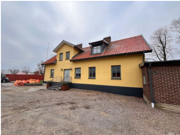
Foto, fasad (bostad)
