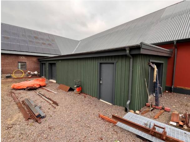
Foto, fasad (verkstad, garage, tvätthall)
