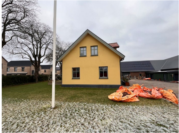
Foto, fasad (bostad, lager, verkstad)
