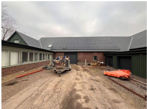
Foto, fasad (kontor, verkstad, garage)
