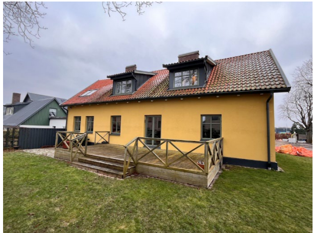
Foto, fasad (bostad)
