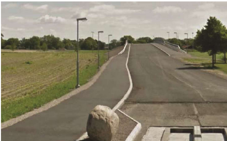
Det planerade bullerskyddet kommer att följa Påarpsvägens nivå och föreslås ligga så nära väggkant som möjligt.
