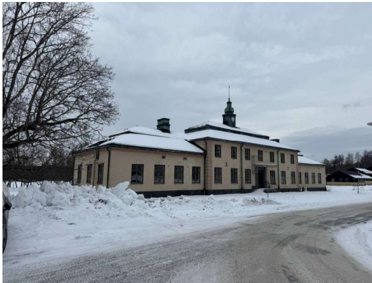
Foto taget utvändigt på värderingsobjektets på ena byggnaden.
