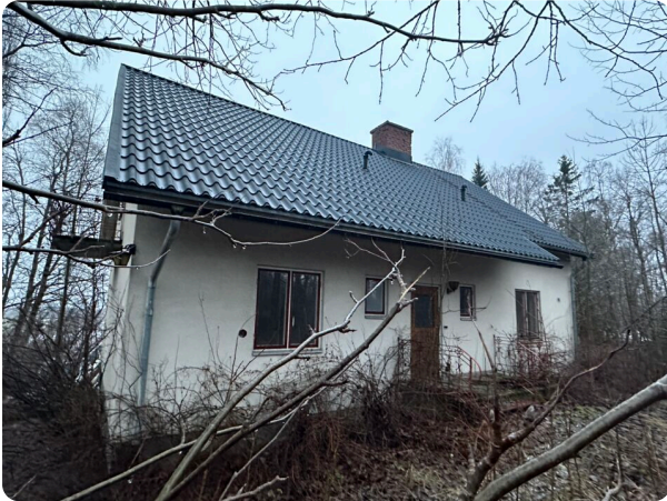
Foto entréfasad bostadshus med ljus putsad fasad
