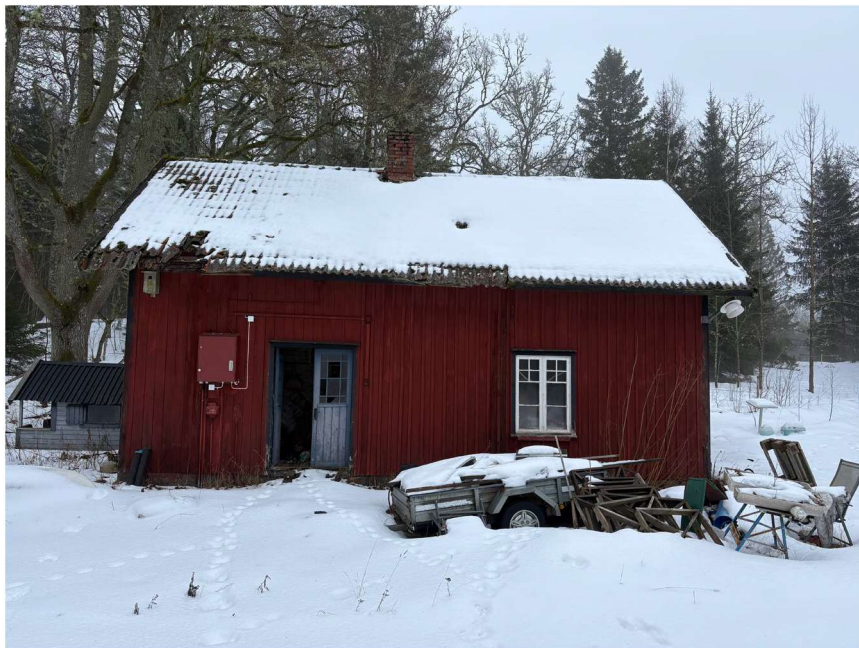
Snickarbod sett från väster.
