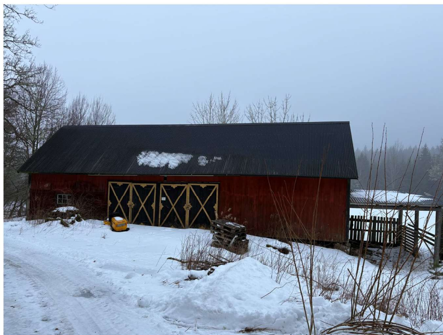
Ladugård sett från öster.
