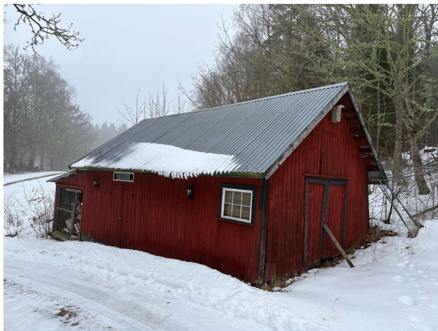
Vedbod sett från väster.
