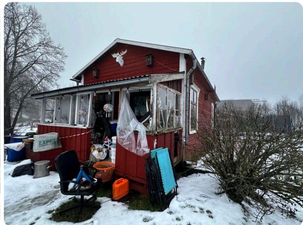
Foto stuga (snickarbod) med röd fasad samt vita detaljer
