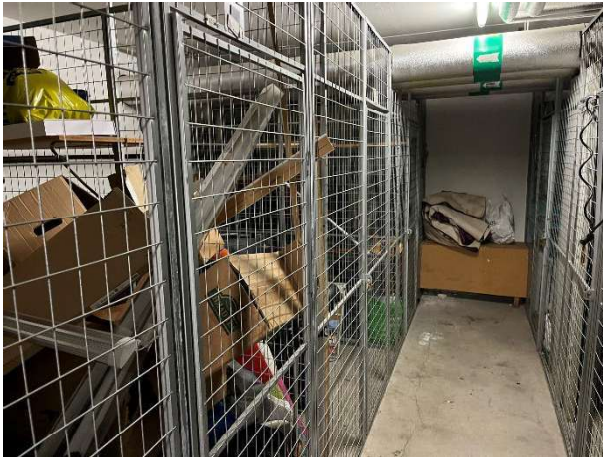
Foto, källare (lägenhetsförråd)
