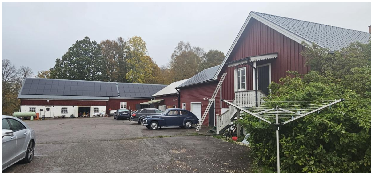
Ekonomibygnader. Större asfalterad gårdspan.
