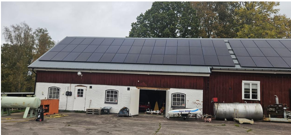
Ekonomibyggnad med förråds- och verkstadsutrymmen. Solpaneler på taket.
