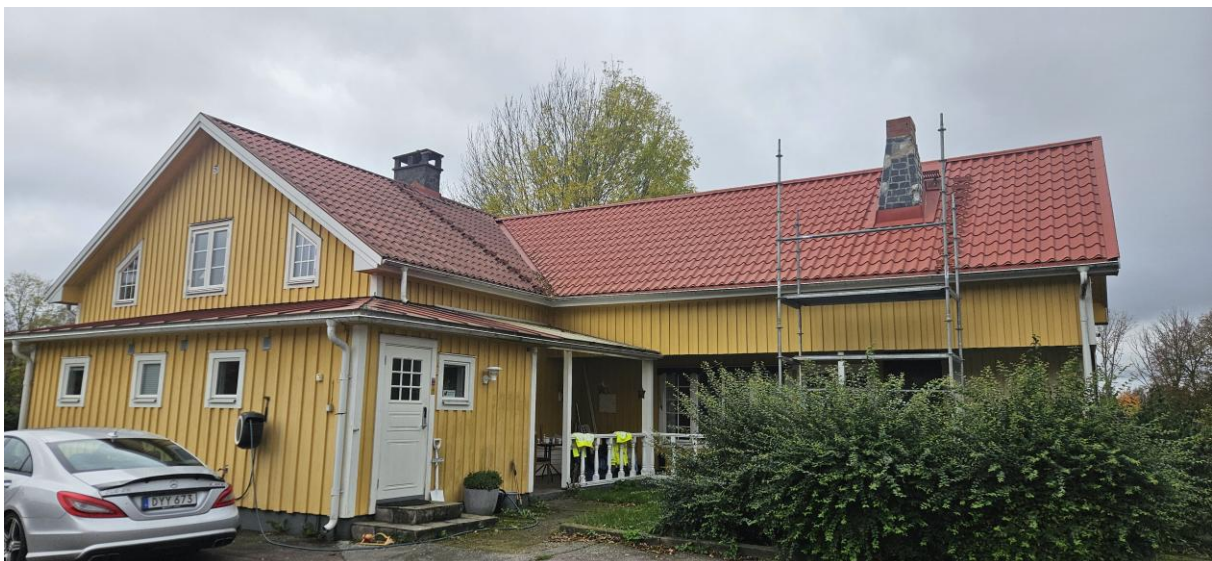
Huvudbyggnad från sidan. Reparation av skorstenen pågår
