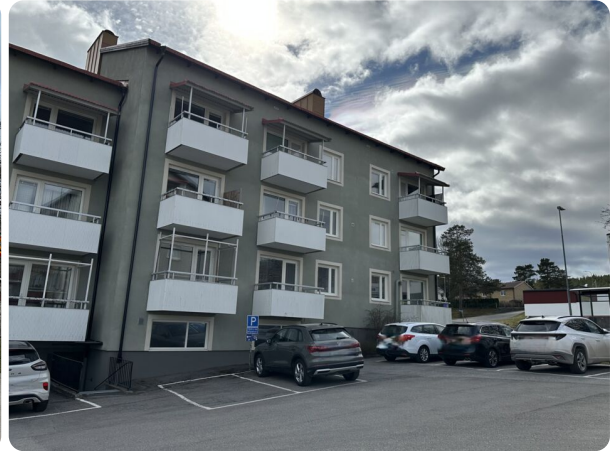
Fasad mot baksidan. Flerbostadshus med grå fasad samt vita balkonger och detaljer
