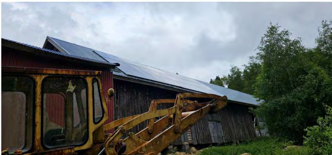
Ladugårdens sydsida med tillbyggd del med monterade solpanel (bild från 2024)
