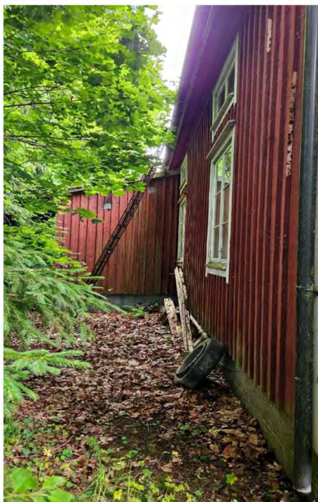
Bostadshus med tillbyggnad (bild från 2024)
