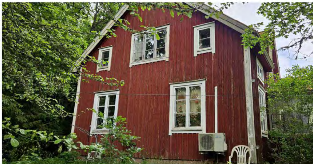
Bostadshus. Gavel mot väster med luftvärmepump (bild från 2024)
