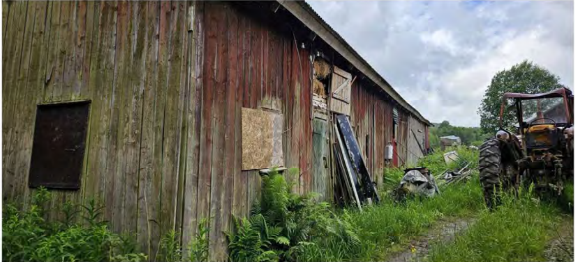
Ladugårdens östra gavel och framsidan mot norr med styrpanel mitt på (bild från 2024)
