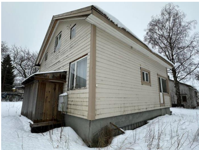
Foto, fasad mot baksidan av bostadshus med beige fasad och vita detaljer. Tomt med snötäcke.
