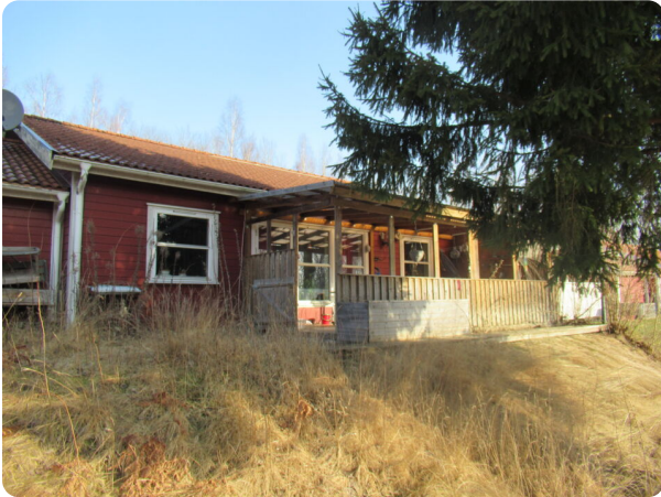
Vy från baksida med altan och delar av tomt i suterräng
