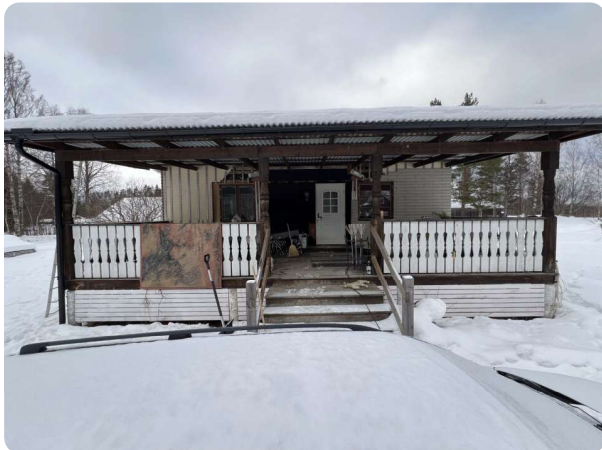
Entréverandan på fasaden mot sydost
