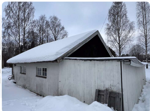
Vidbyggt förråd mot garagets baksida
