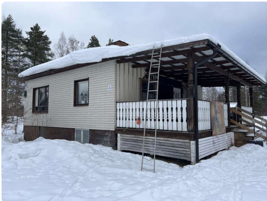
Bostaden sedd från söder. Fasad av ljus tegelklinker.
