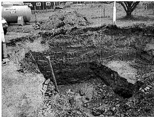
Foto 3. Det norra cisternläget där båda cisternerna togs upp.
