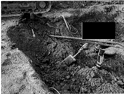
Foto 1. Friläggning av cisternen mitt framför boningshuset.
