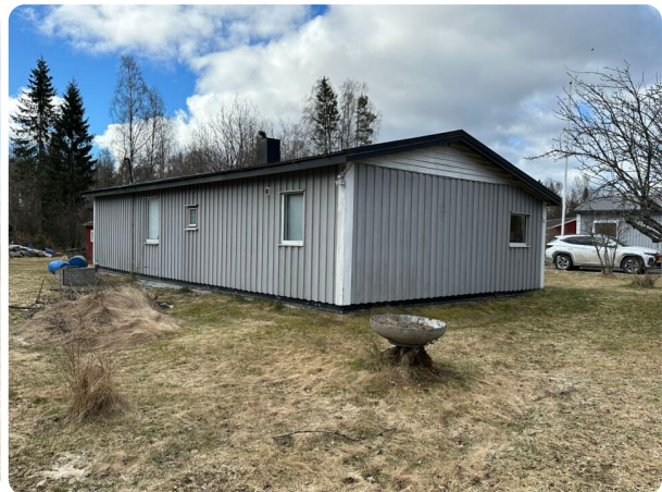
Gavelfasad mot vägen
