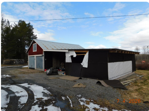
Garage samt tillbyggnad, södra sidan.
