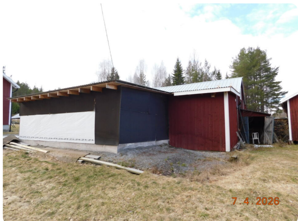
Garage samt tillbyggnad, norra sidan.
