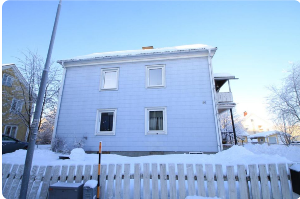
Foto huvudbyggnad, ljusblå eternitpanel, vita detaljer.
