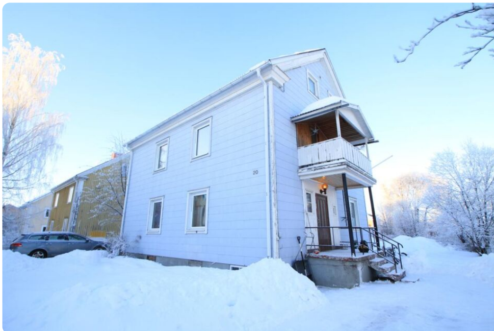
Foto huvudbyggnad, ljusblå eternitpanel, vita detaljer.
