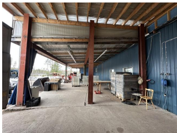
Skärmtak med stålstomme
