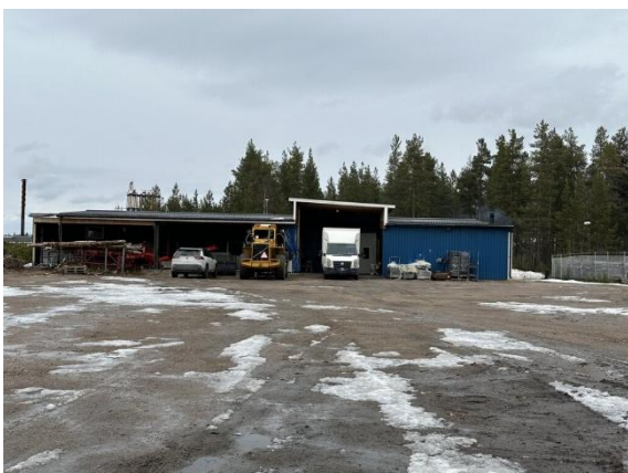
Industribyggnad. Vy från kör- och uppställningsyta
