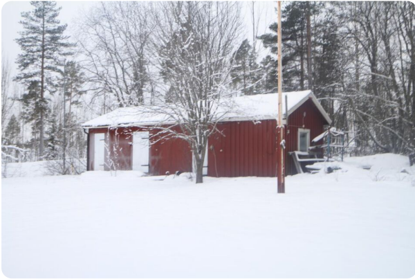
Foto förråd, rödmålad träpanel, vita detaljer, snö på mark och tak.
