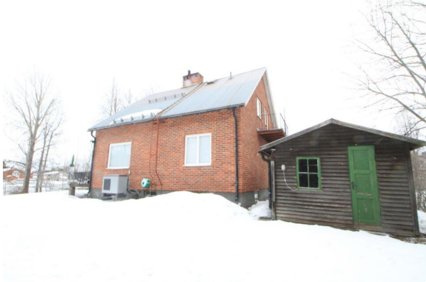
Foto huvudbyggnad, röd tegelpanel, vita detaljer, snö på mark.
