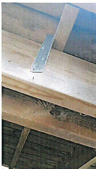
Foto under altankonstruktionen, bärlina och altangolv
