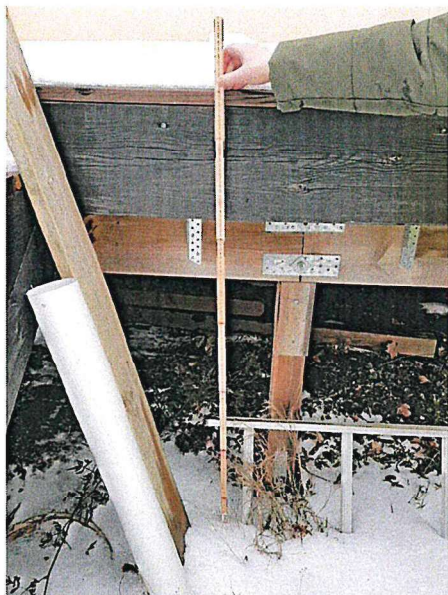
Foto 7, altan på huvudbyggnadens södra fasad. Från mark till överkant altangolv (högsta punkt) ca 1.3m. Från mark till underkant träkonstruktion (bärlina) ca 0.9.
