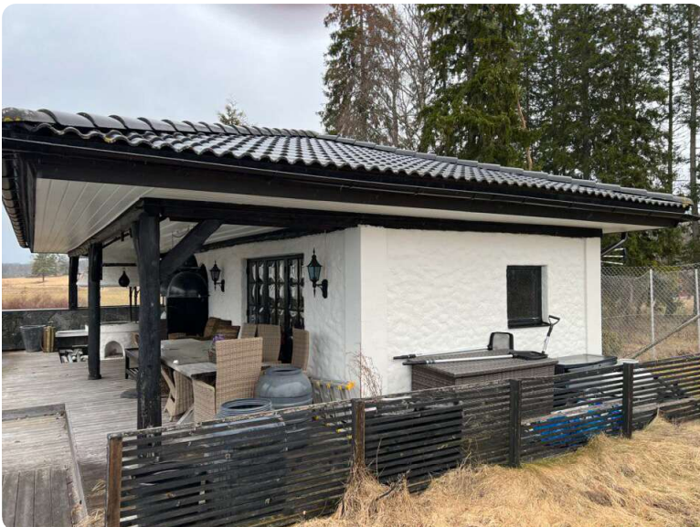
Poolhus vitrappat med betongtegel
