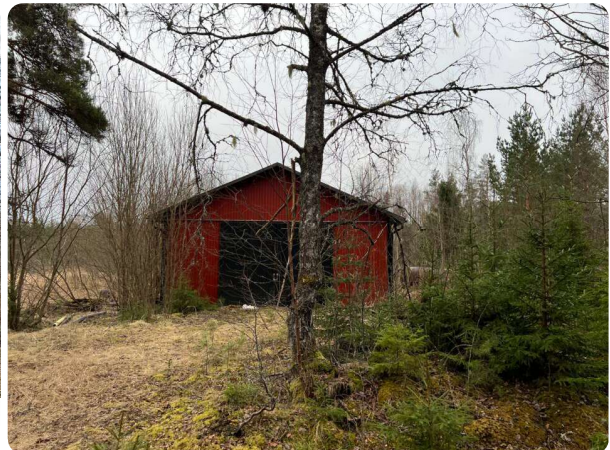
Lada med rödmålad plåttfasad och plåttak
