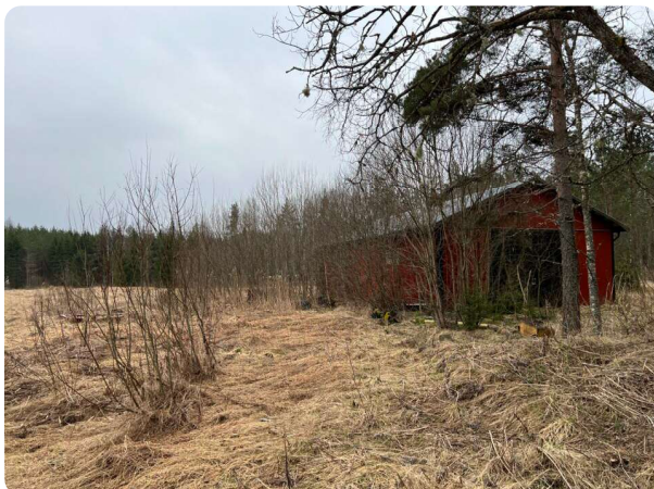
Lada med rödmålad plåttfasad och plåttak
