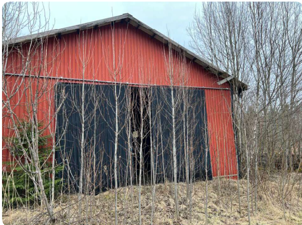
Lada med rödmålad plåttfasad och plåttak
