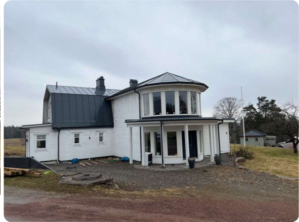
Huvudbyggnad vitmålad träpanel med plåttak
