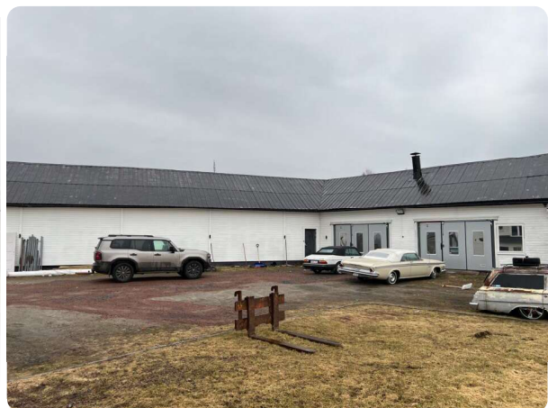
Verkstad med vitmålad träpanel och plåttak med skjutportar
