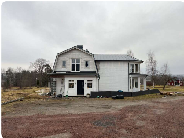
Huvudbyggnad vitmålad träpanel med plåttak
