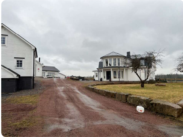
Huvudbyggnad vitmålad träpanel med plåttak samt kontor med infart i förgrunden
