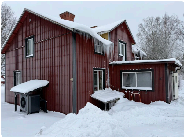
Huvudbyggnadens gavel. Nyinstallerad LVP ses i bild.
