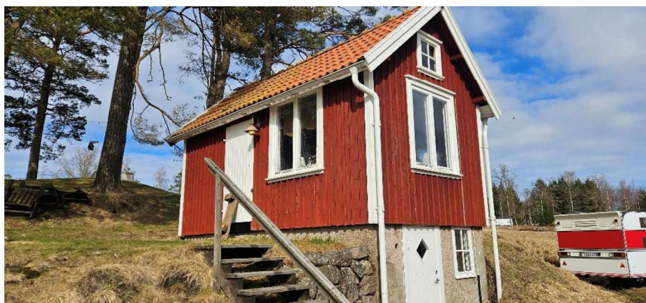
Uthus med jordkällare
