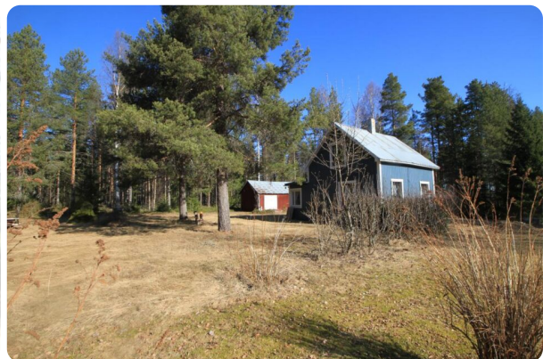
Foto byggnader och tomt, gråmålad träpanel med vita detaljer, plåttak.
