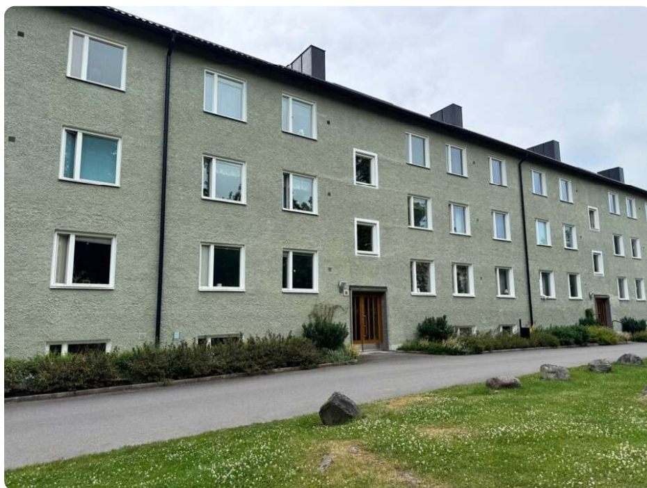
Huvudobjekt, ljus tegelfasad med vita detaljer
