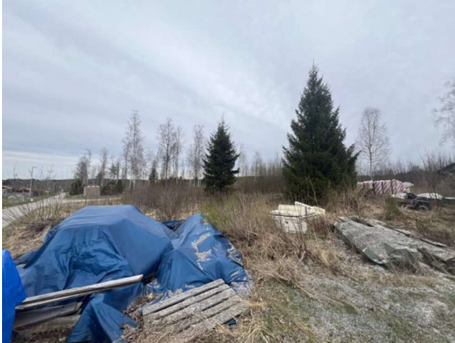
Foto, mark med sly och bråte.
