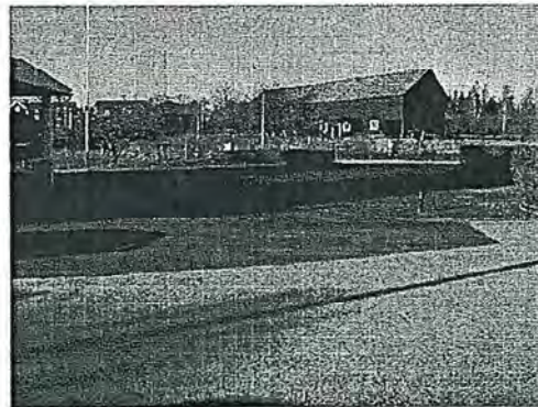
Foto 6. Fastigheten efter återställningen.
