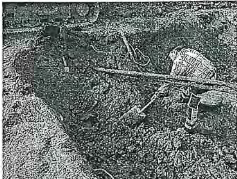
Foto 1. Friläggning av cisternen mitt framför boningshuset.
