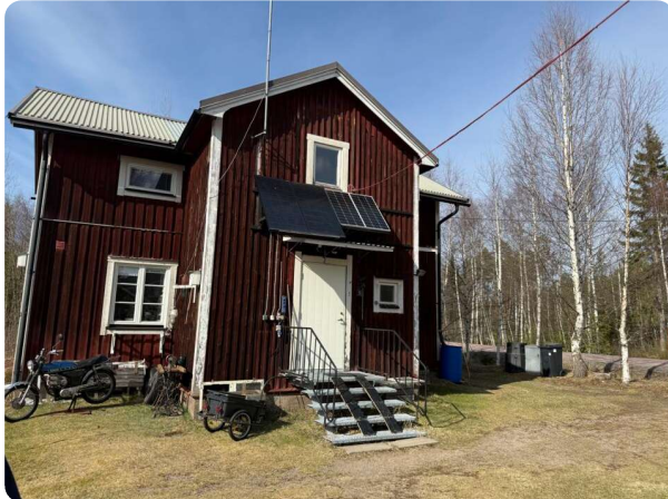
Huvudbyggnadens framsida med entré
