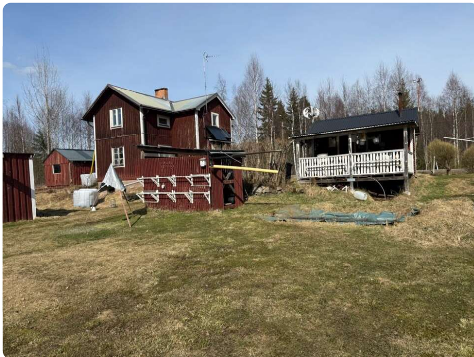
Översiktsbild av värderingsobjektet med rödmålade byggnader och vita detaljer
