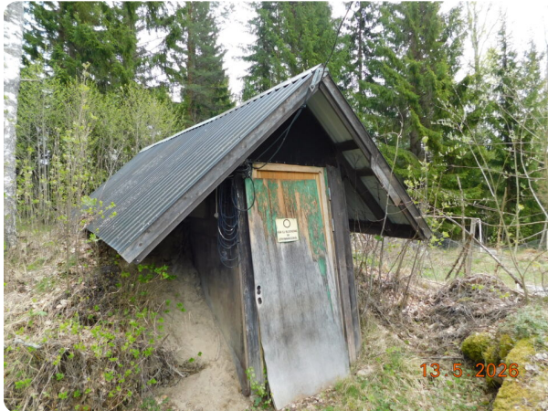
Foto, jordkällare, plåttak.
