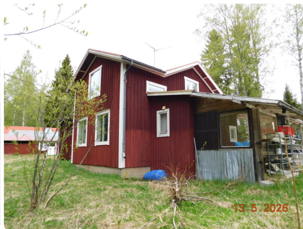
Foto, huvudbyggnad, baksida, rödmålad träpanel med vita detaljer, altan med tak.
