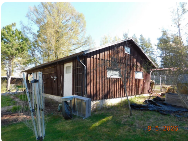
Dubbelgarage med carport, brun träfasad och plåttak.
