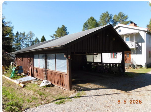
Dubbelgarage med carport, brun träfasad och plåttak.
