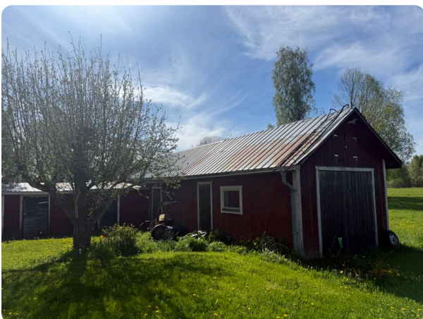
Garage-och förrådsbyggnad byggt i vinkel
