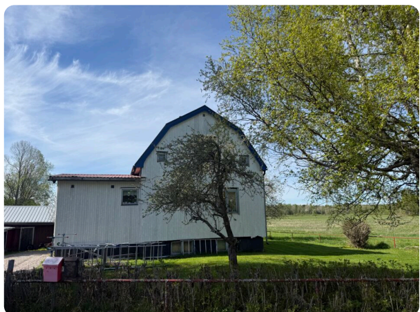
Vy från vägen över värderingsobjektet med byggnad och tomtmark
