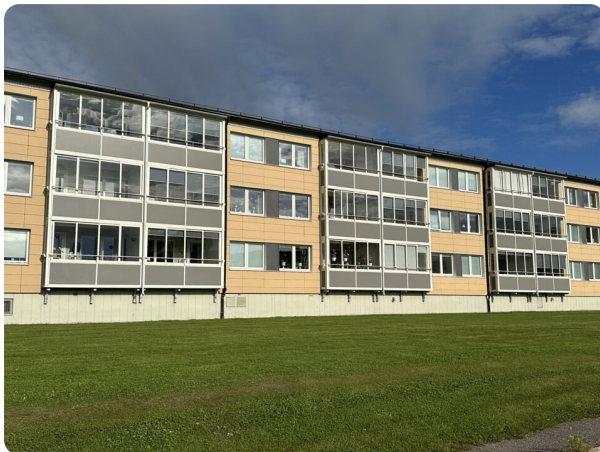
Fasad mot baksidan med inglasade balkonger
