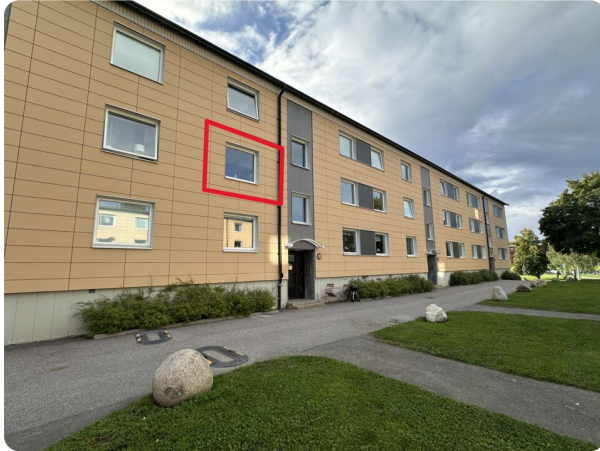
Entréfasad, markeringen visar läget för lägenheten
