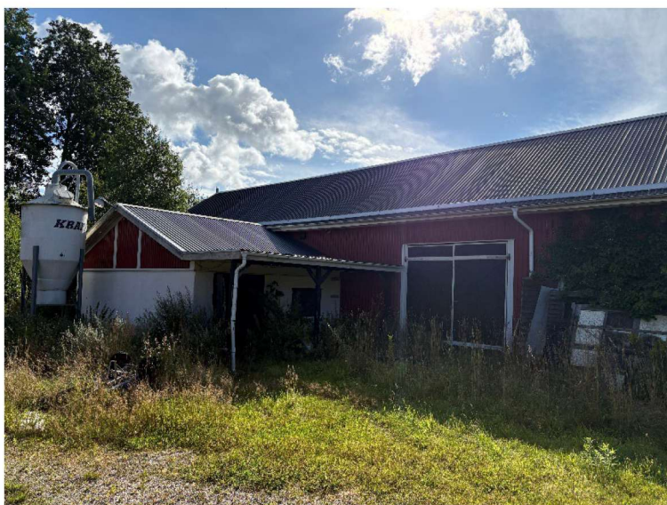
Stallbyggnad med ingång under taket i vinkel. Ingång till Logdel genom dörrar till höger i bild.
