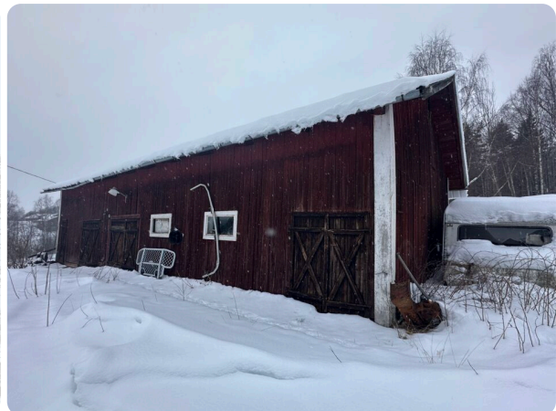
Ekonomibyggnad (fd) med röd täpanel samt vita detaljer
