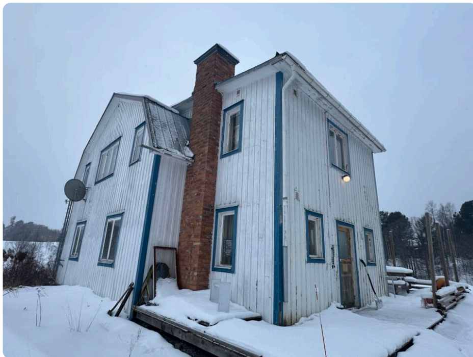
Huvudbyggnad med ljus fasad samt blåa detaljer. Tomt med snötäcke
