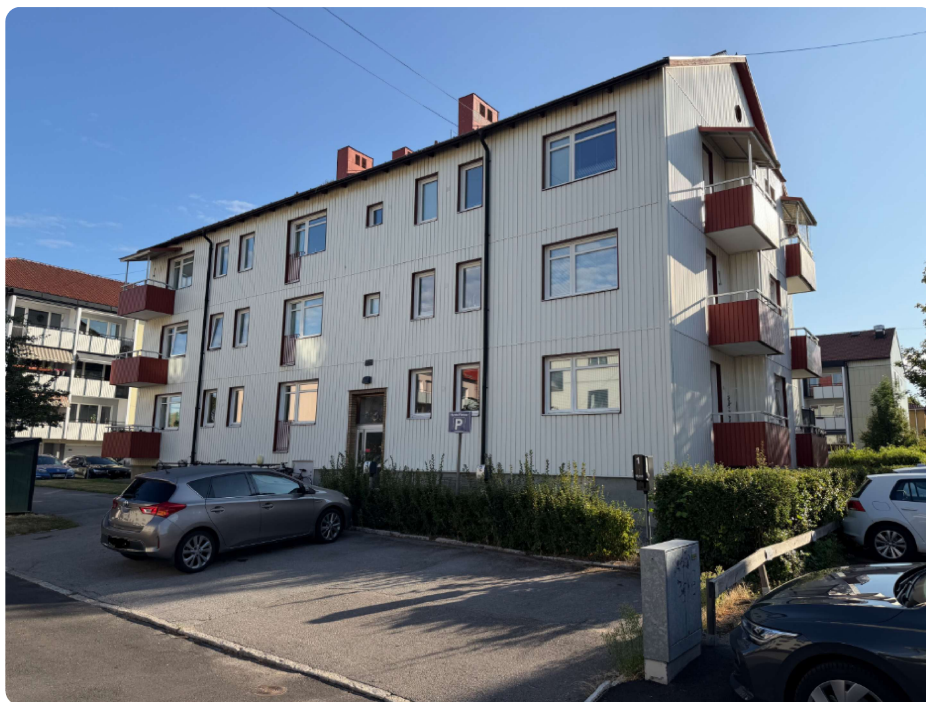
Huvudobjekt, flerbostadshus med vit fasad.
