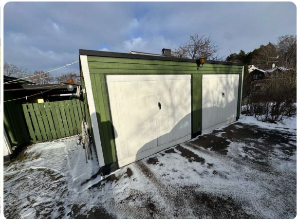
Övrig byggnad, garage
