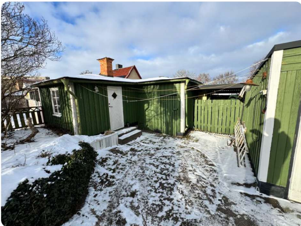
Övrig byggnad, förråd
