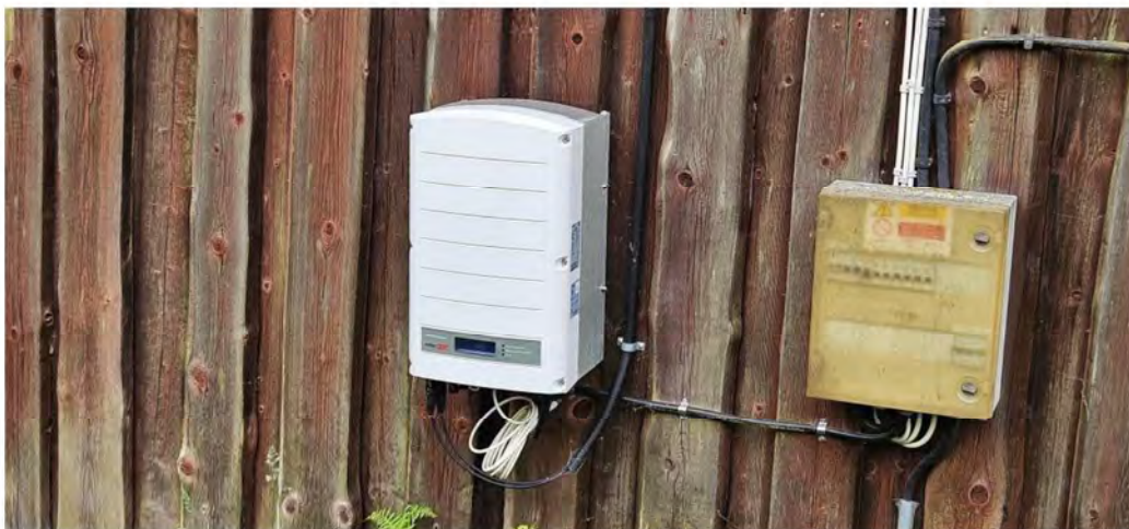
Styrenhet för solpanel (bild från 2024)
