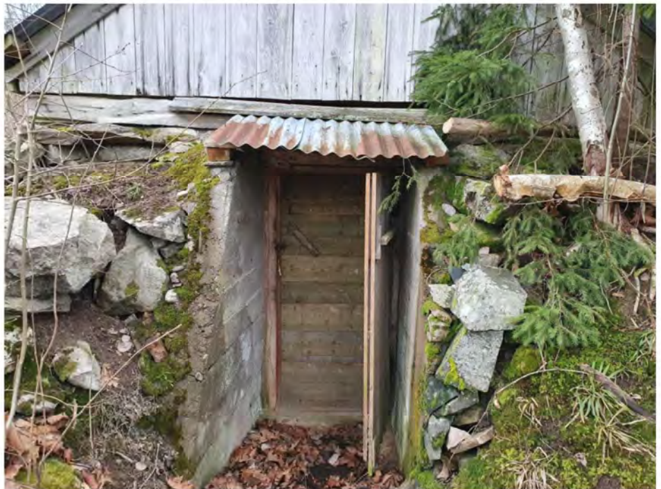
Jordkällare (bild från 2024)
