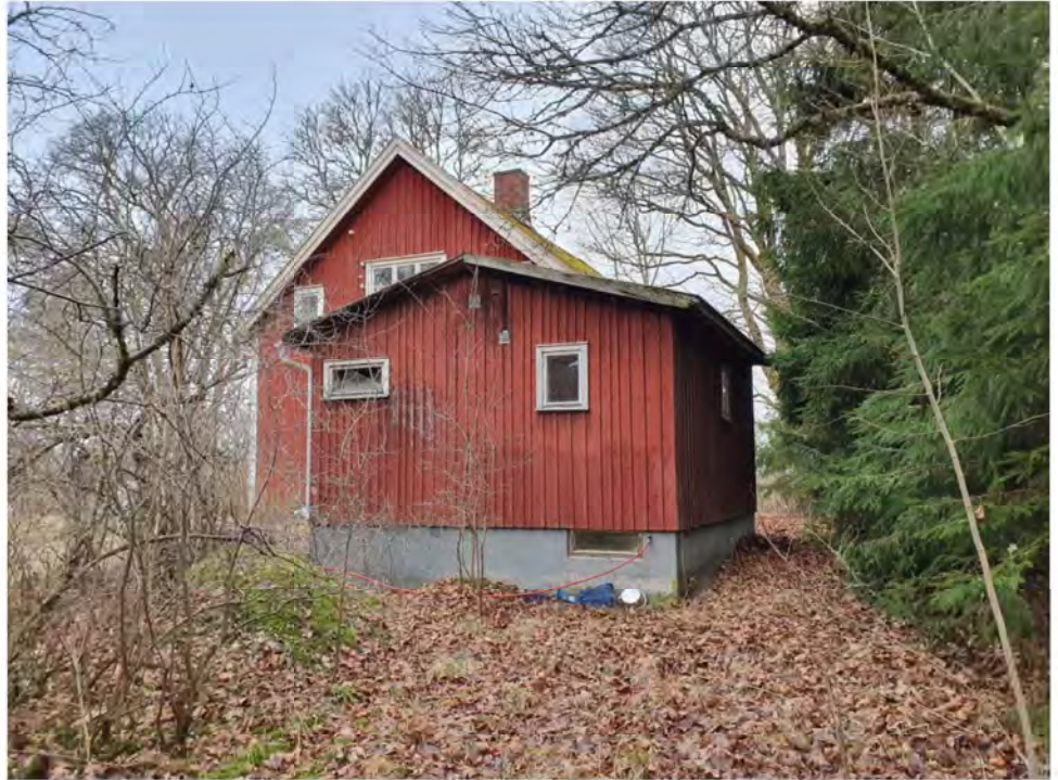
Bostadshus. Tillbyggnad med källare (bild från 2024)
