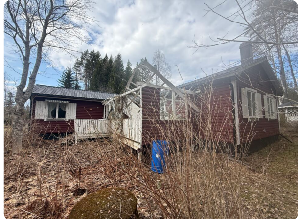
Huvudbyggnadens baksida med skadad altan
