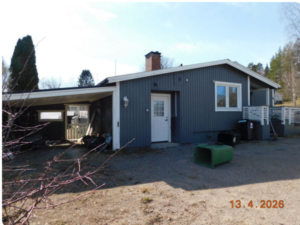
Småhusbyggnad, entréside, gråmålad träpanel med vita detaljer, carport till vänster.
