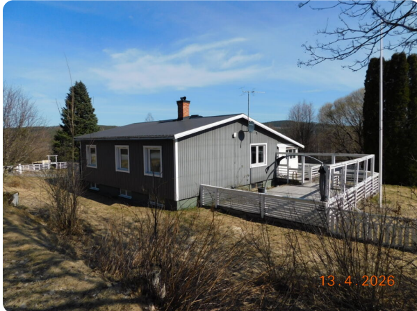
Småhusbyggnad, gråmålad träpanel med vita detaljer, altan med trädäck.
