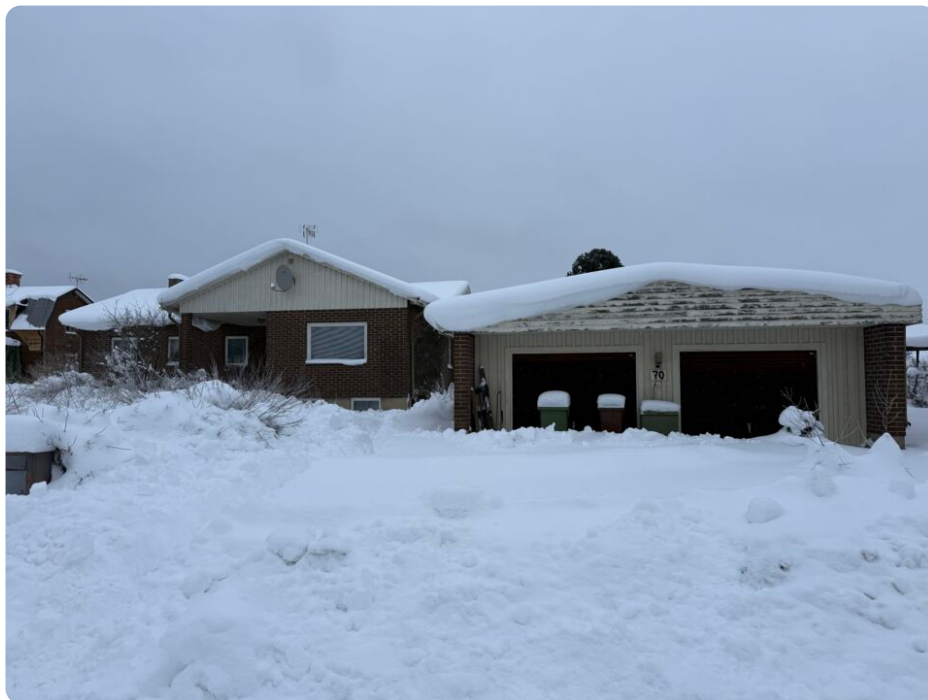
Värderingsobjektets framsida. Huvudbyggnad och garage ses i bild. Snötäckta markytor.
