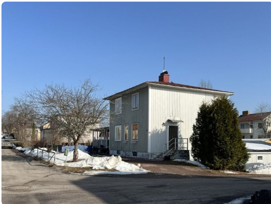
Bostadshusets fasader mot sydväst
