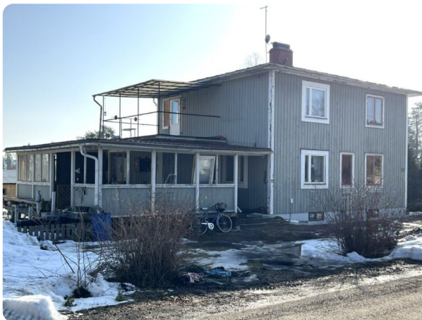
Bostadshusets fasader mot nordväst
