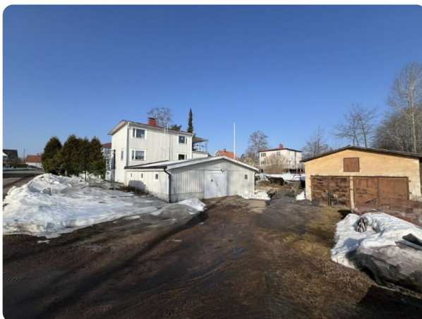
Bostadshus, vidbyggt stort varmgarage samt kallgarage
