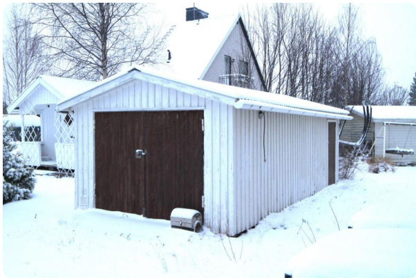
Foto garage, vit träpaneö bruna garagedörrar.
