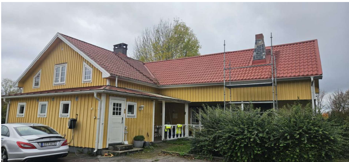
Huvudbyggnad från sidan. Reparation av skorsten pågår
