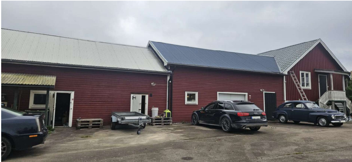
Ekonomibyggnad med lägenhet/lokalytor på övervåning
